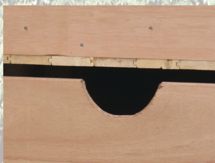
Aan de zijkant van de zaadkisten zit een gat waardoor meet-apparatuur in de kist gehangen kan worden.
